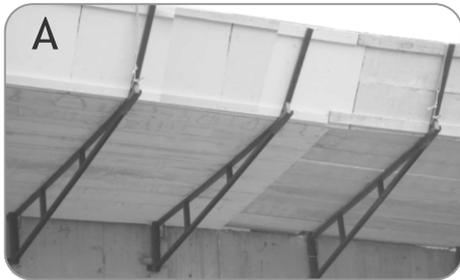
A) A maneira mais fácil e segura para a instalação do aparalixo exigirá a preparação das esperas (Figura B) que deverão ser concretadas nas lajes que receberão as bandejas de proteção.
